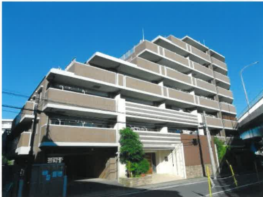
① 本建物を含む一棟の建物の外観（西方向から撮影）
