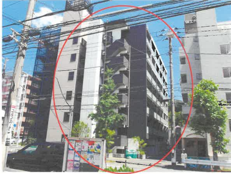
① 目的建物全景
