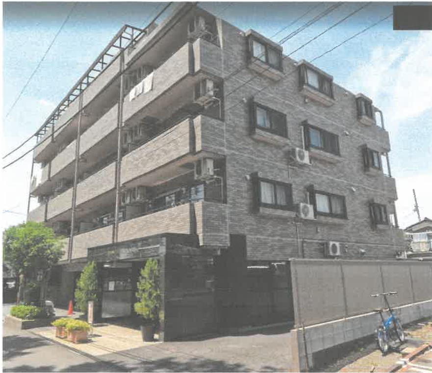
① 全景（南東側から撮影）
