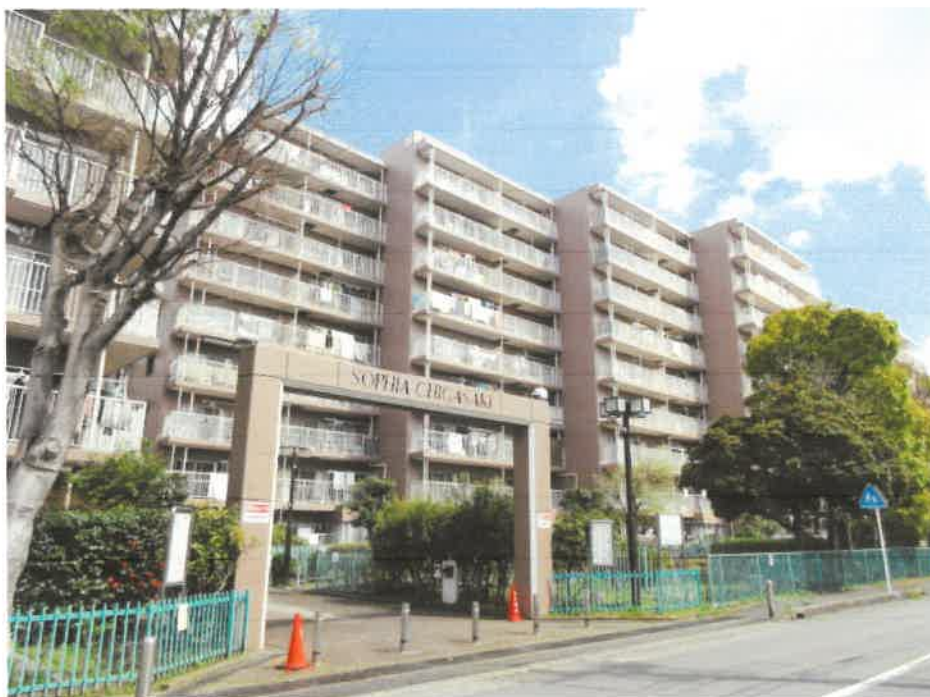
物件 1 の存する一棟の建物
