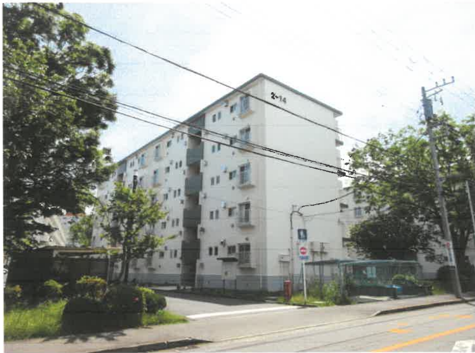
物件 1 の存する一棟の建物
