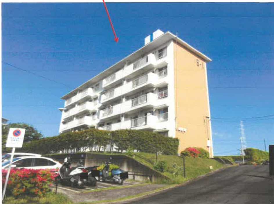
物件 1 の存する一棟の建物
