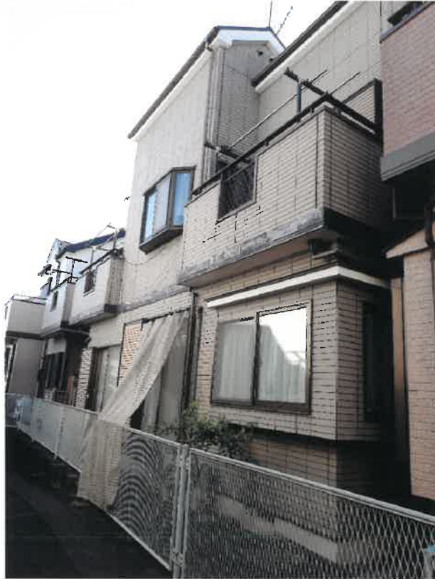
① 目的物件南東側の状況
