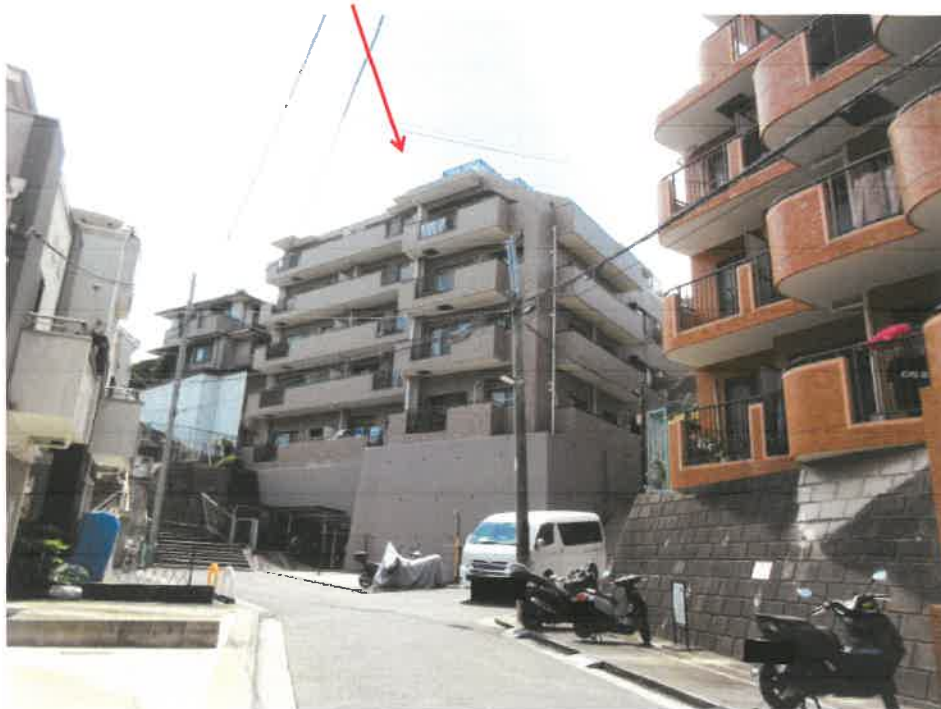
物件 1 の存する一棟の建物
