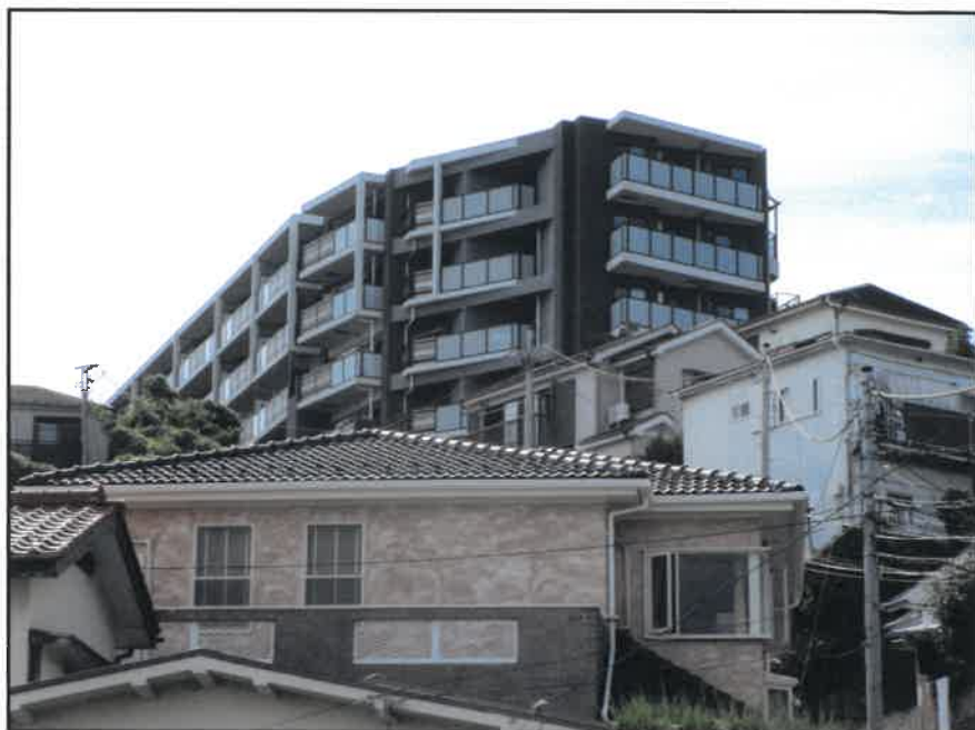
① 一棟の建物の外観(南東側から撮影)
