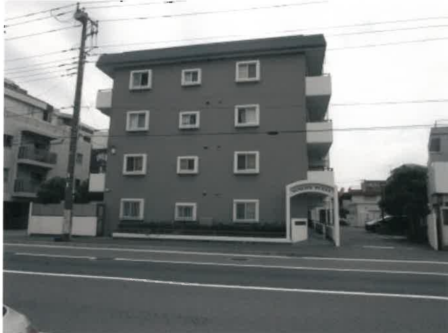
① 本建物を含む一棟の建物の外観（東方向から撮影）
