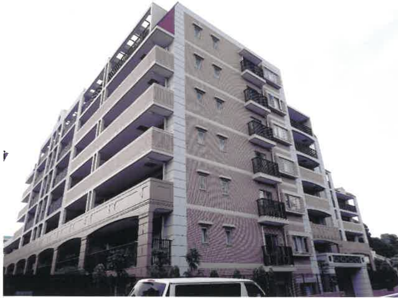
① 目的物件南東側の状況
