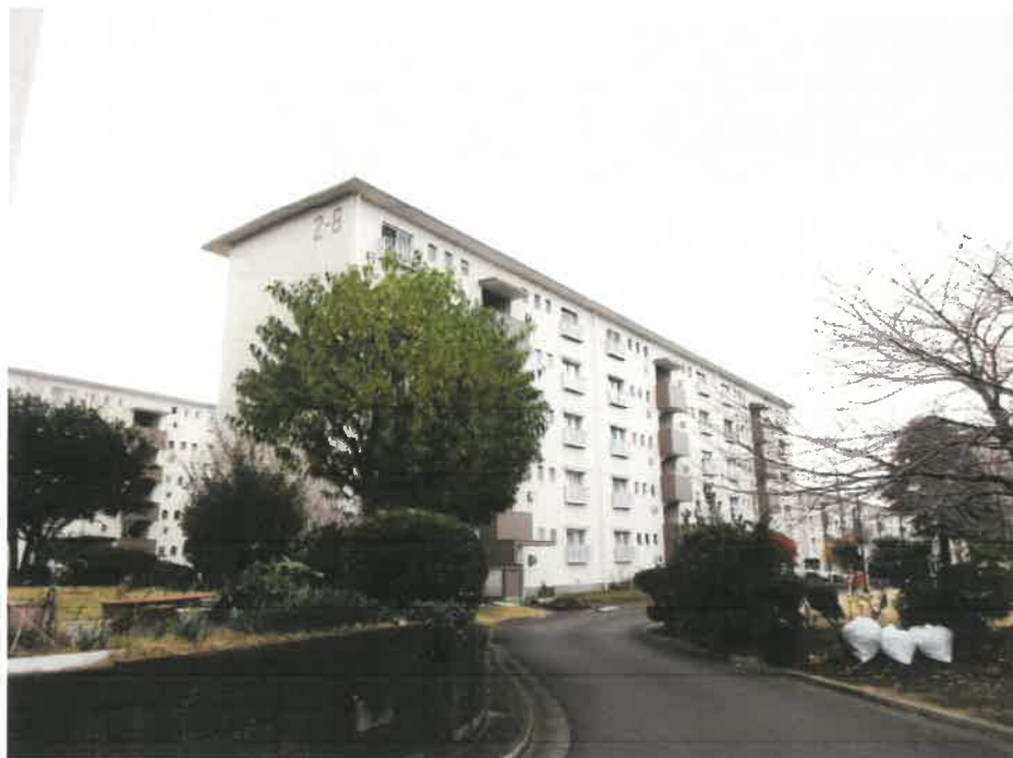
物件 1 の存する一棟の建物
