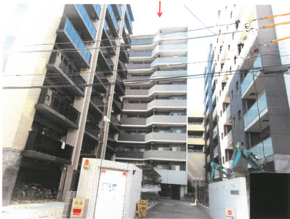
物件 1 の存する一棟の建物
