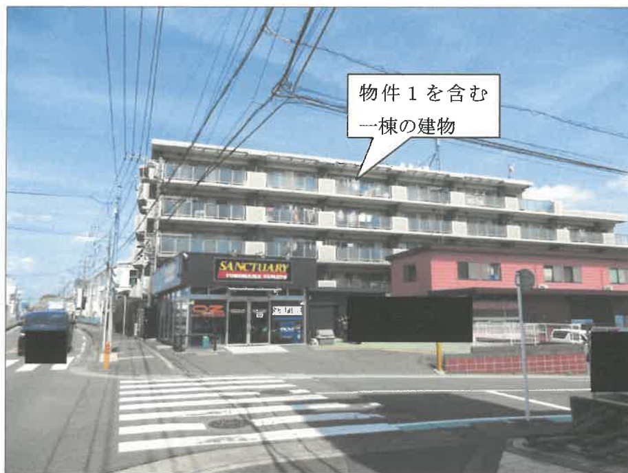
①外観（南西方向から撮影）
