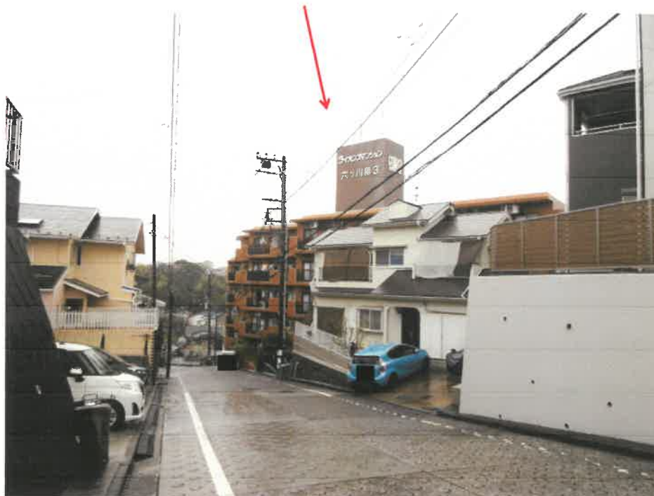
物件 1 の存する一棟の建物
