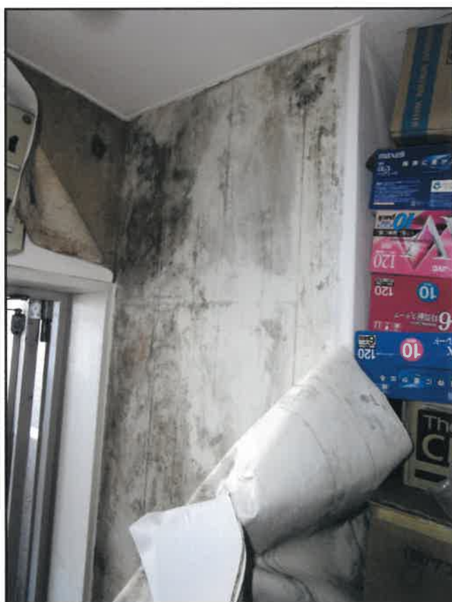
⑧ 建物内の状況ー玄関周辺の壁面クロス
