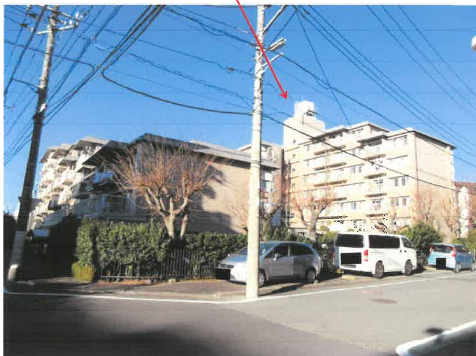
物件 1 の存する一棟の建物
