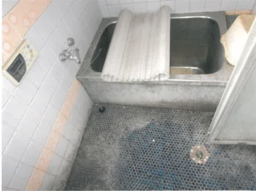
⑤ 建物内の状況
