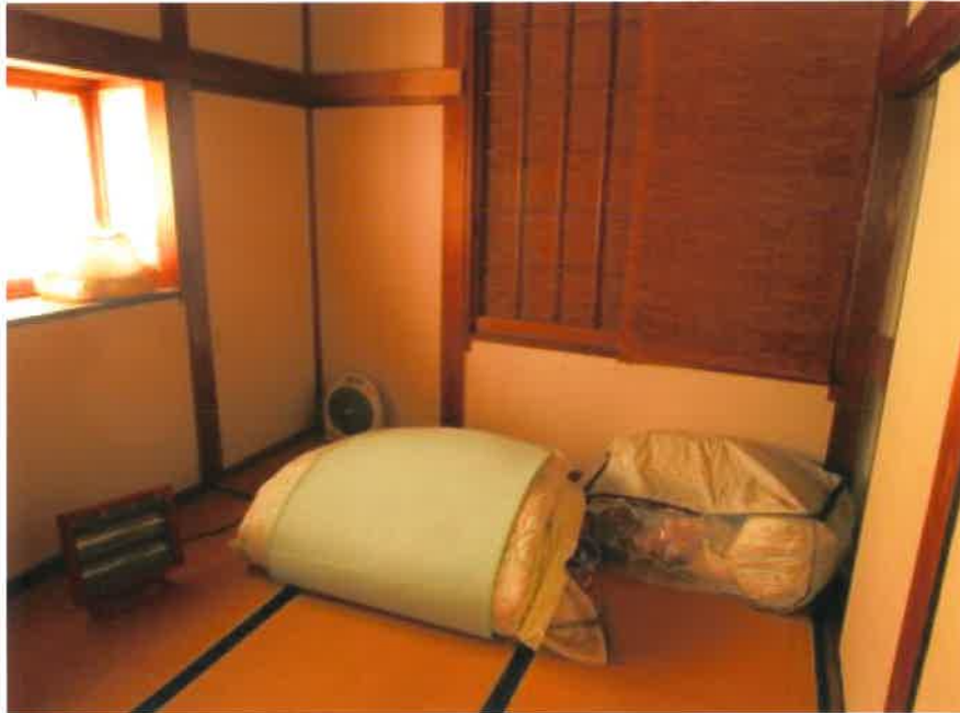
⑥ 建物内の状況
