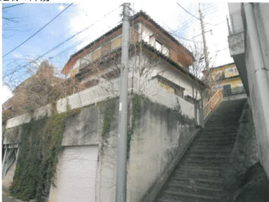
① 本建物の外観
