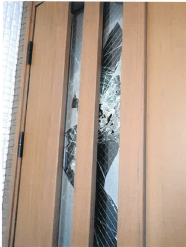
⑥玄関ドア損壊の状況
