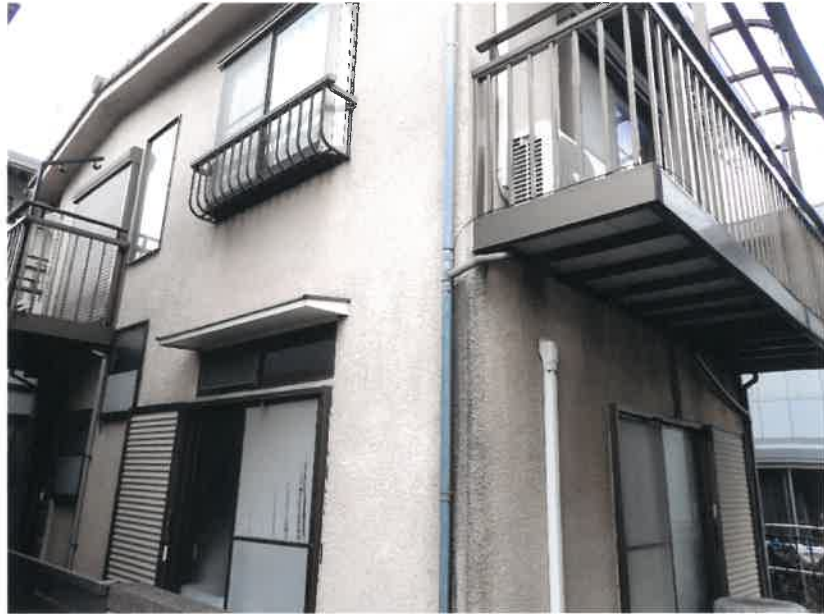
① 目的物件南東側の状況
