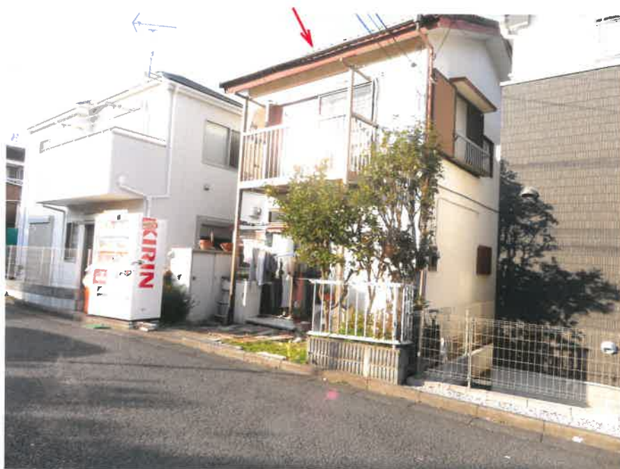
① 建物の外観（南東側から撮影）
