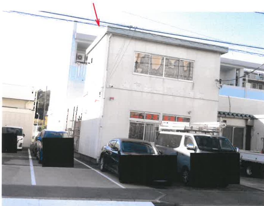
① 専有部分の建物の外観（東側から撮影）
