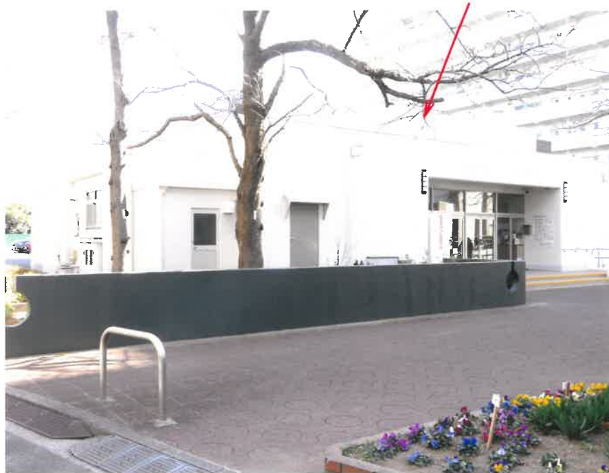
⑦ 物件3建物（集会所）の状況（北西側から撮影）
