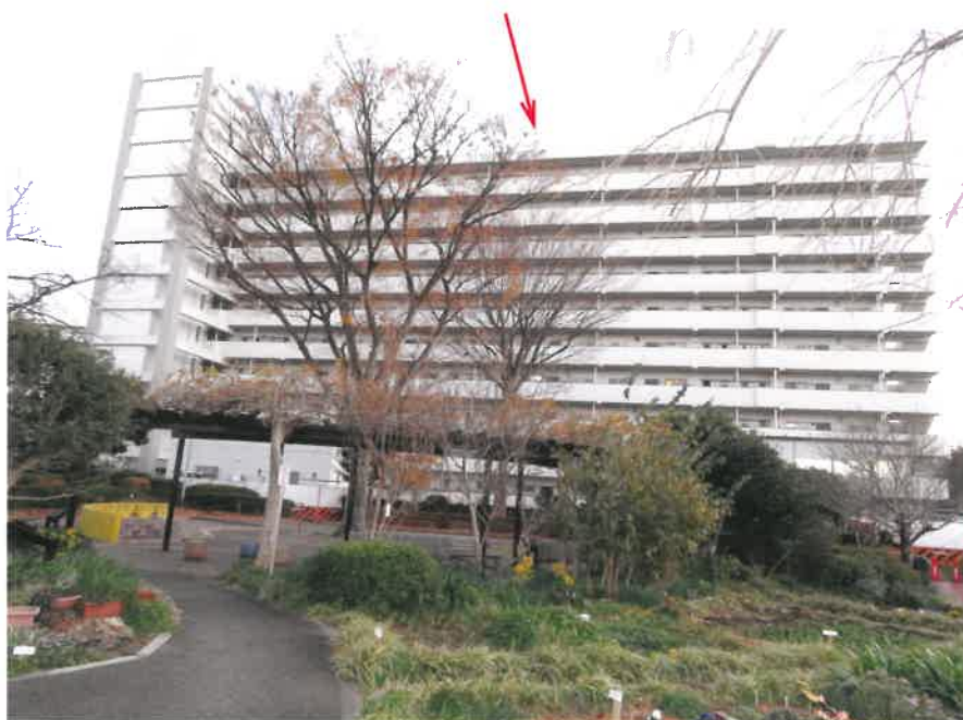
① 一棟の建物の外観（物件1）（北側から撮影）
