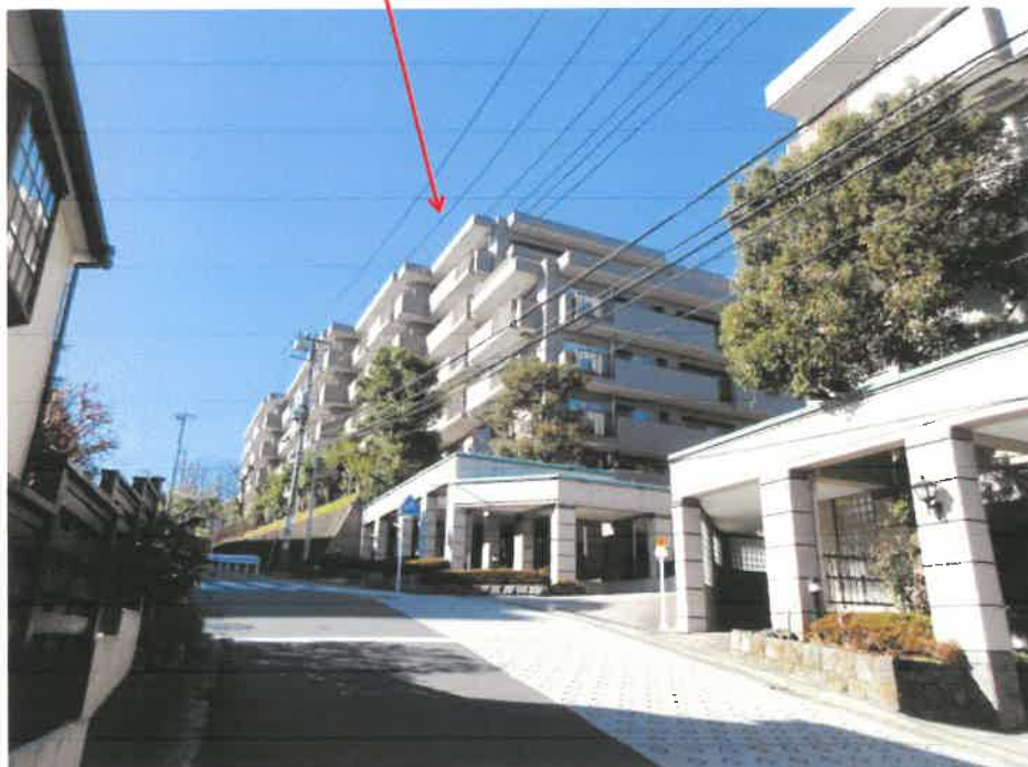
物件 1 の存する一棟の建物
