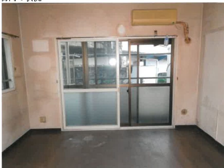
② 建物内の状況
