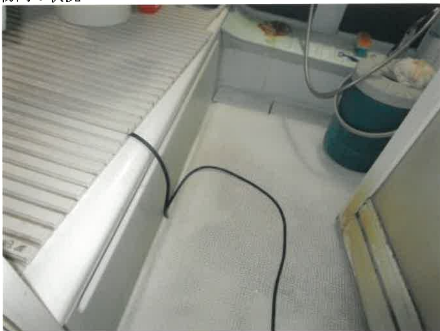
② 建物内の状況
