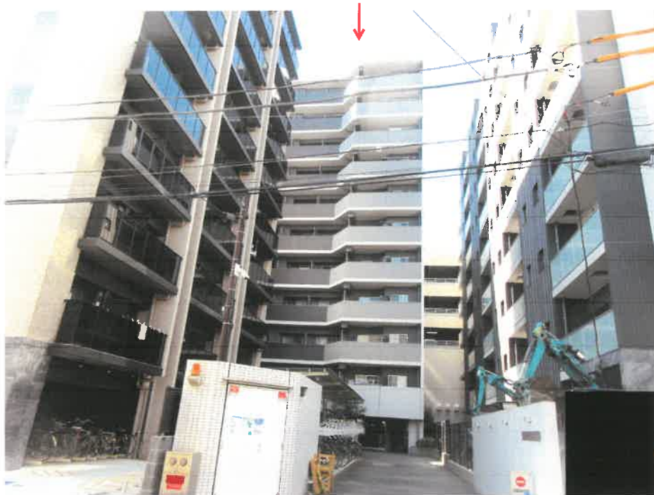
物件 1 の存する一棟の建物
