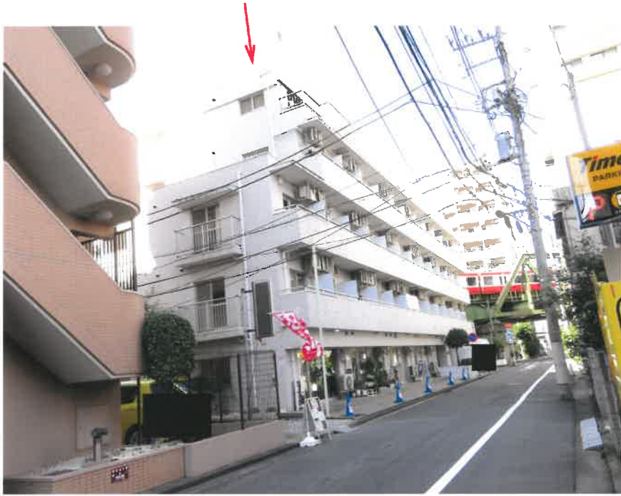
① 一棟の建物の外観（南東側から撮影）
