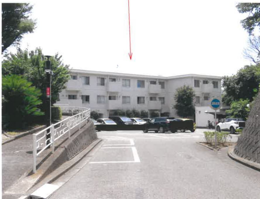
① 一棟の建物の外観（西側から撮影）
