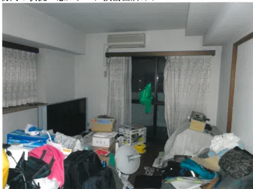
② 建物内の状況 窓ガラスに損傷箇所あり
