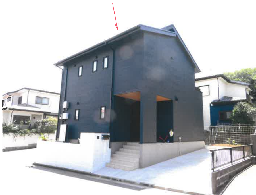
① 建物の外観（北西側から撮影）
