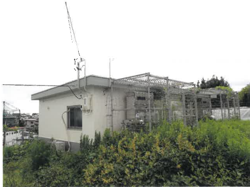
⑤ 物件 2 ポンプ室の状況
