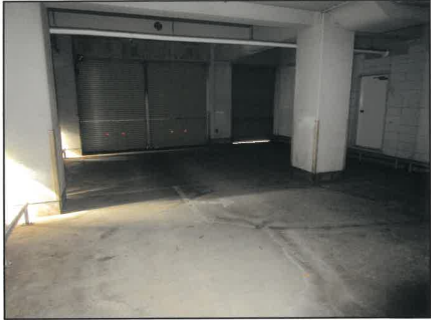
⑤ 建物内の状況－バイク置場・自転車置場(1階)
