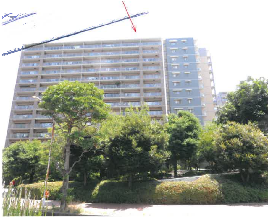
① 一棟の建物の外観（西側から撮影）
