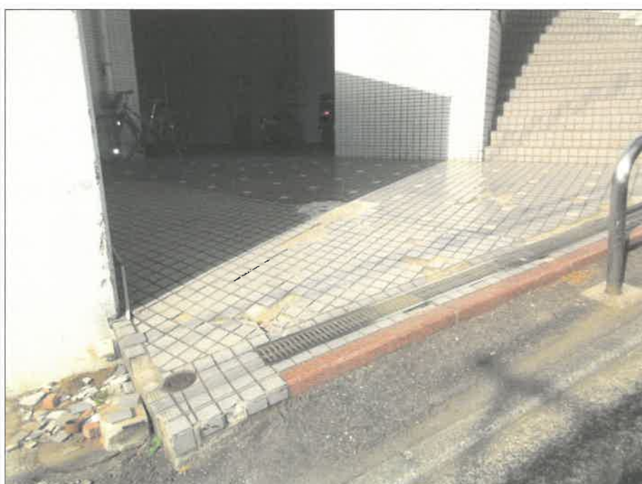
⑥南東方向からマンション敷地を撮影
