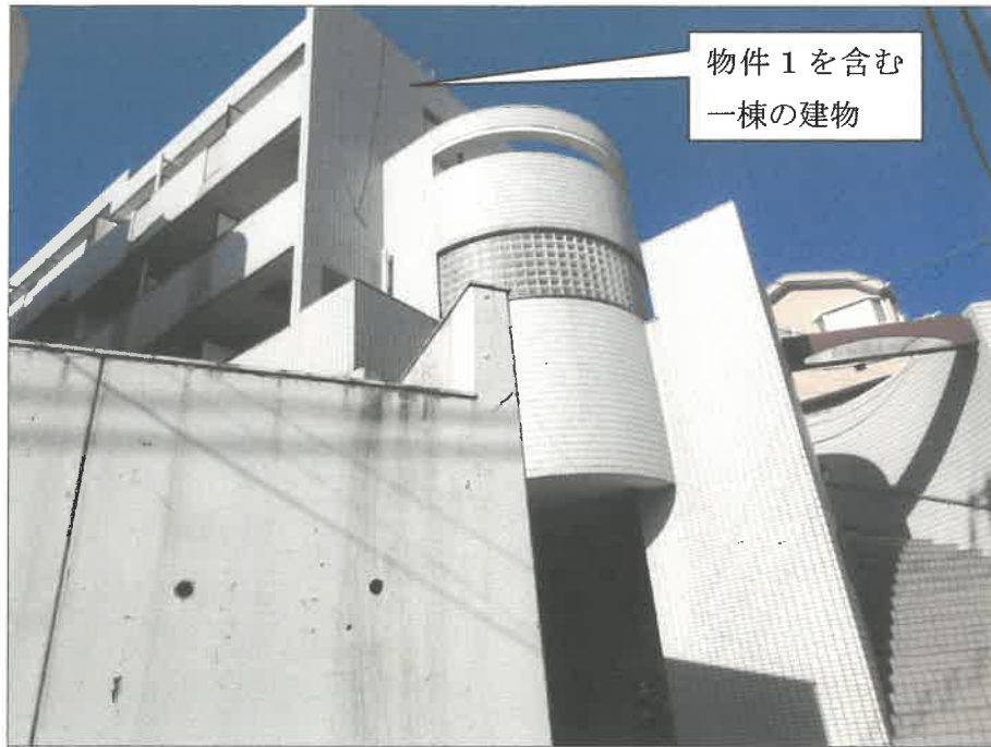
①外観（南東方向から撮影）
