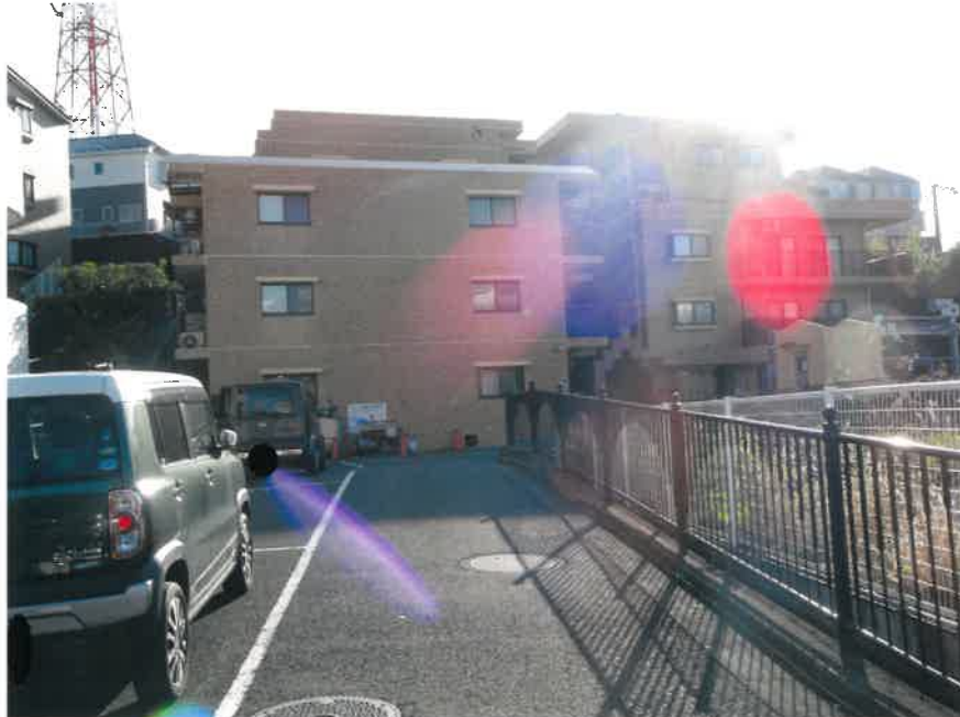
① 本件建物を含む一棟の建物の外観（北方向から撮影）
