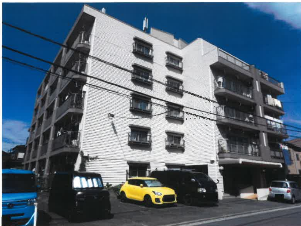
①物件2を含む建物の外観
