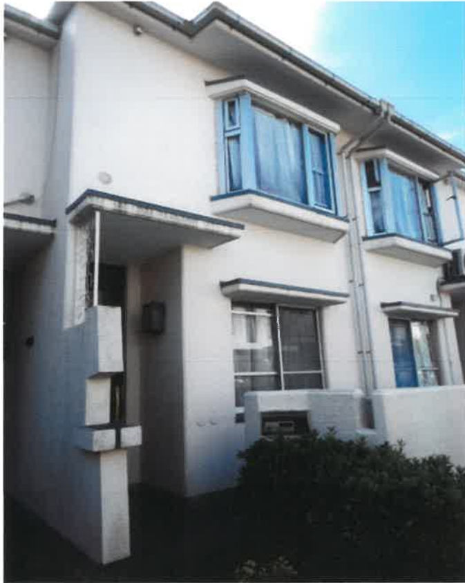
①物件1の建物の外観
