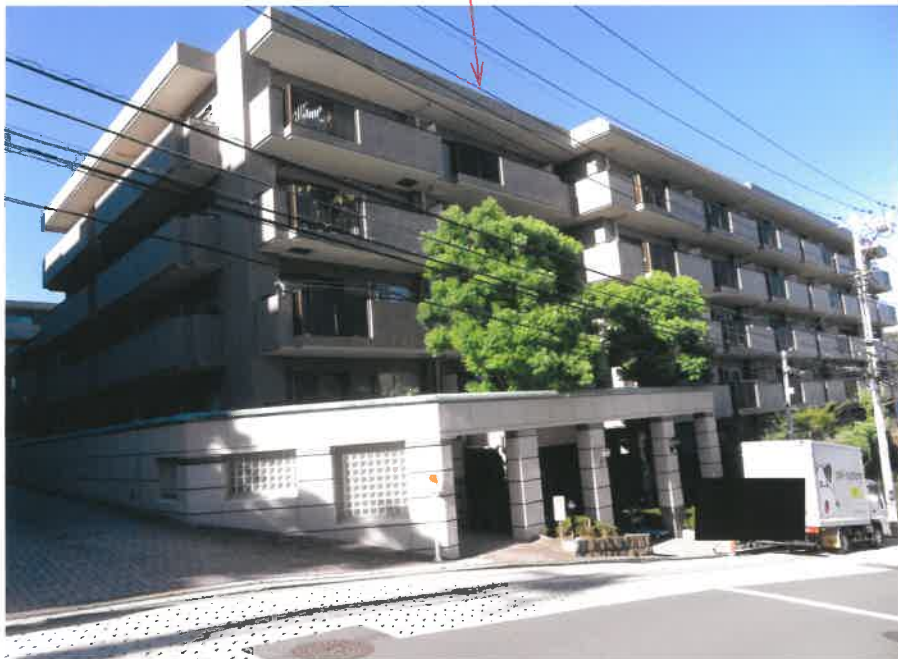
① 一棟の建物の外観（南西側から撮影）
