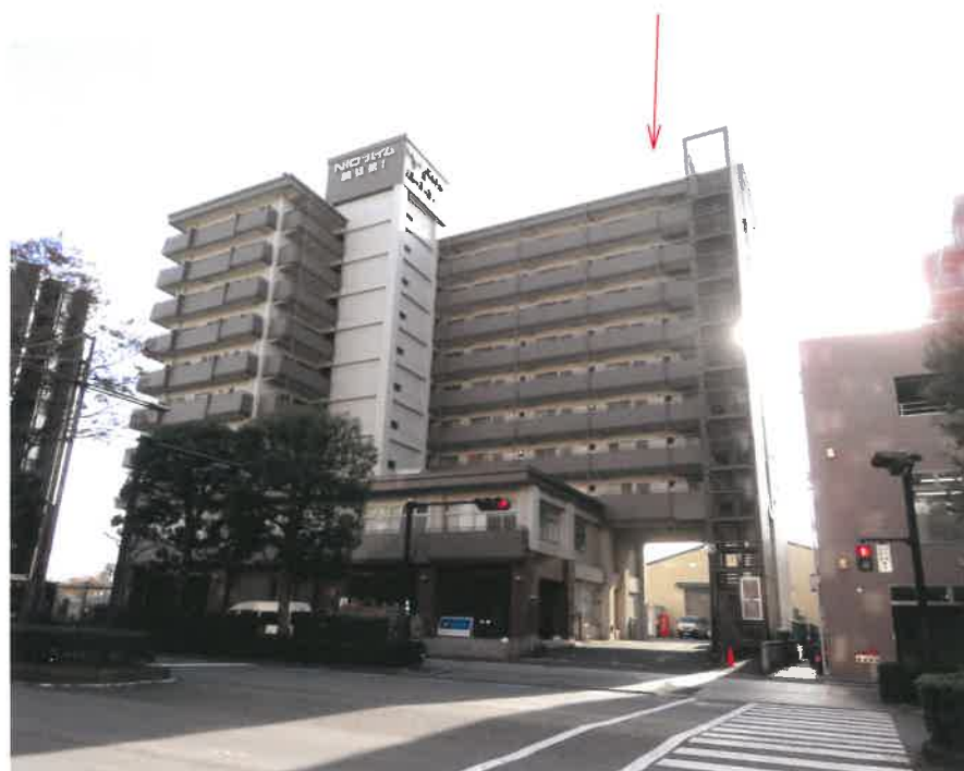
① 一棟の建物の外観（北東側から撮影）
