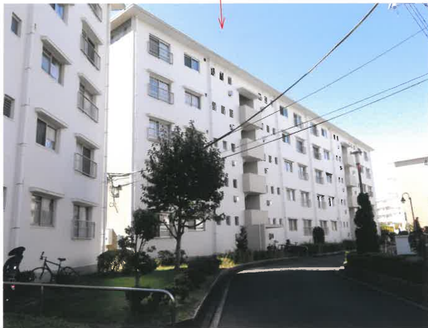
① 一棟の建物の外観（北東側から撮影）
