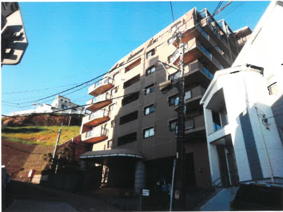
①物件 1 を含む建物の外観
