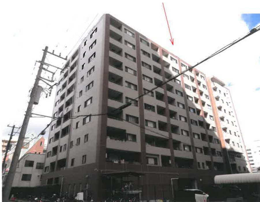
① 一棟の建物の外観（南西側から撮影）
