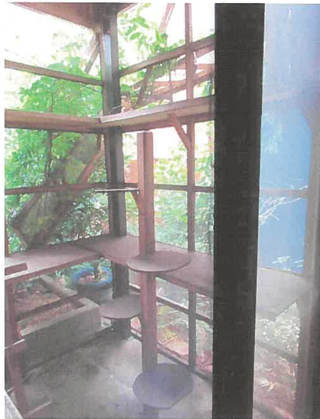
物件2・1階東端の一部滅失部分
